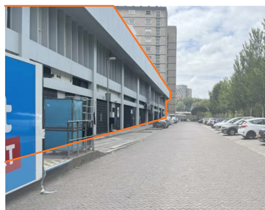
Achterkant winkelcentrum met logistiek en parkeren
